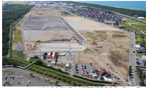
小松市安宅新地区土地区画整理事業造成工事(2工区)
