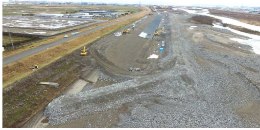
手取川舟場島急流河川対策工事(ICT対象現場)
